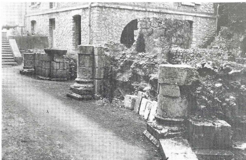
Vestiges du déambulatoire avec les bases des colonnes. Le tombeau de Jean de Salisbury est situé sous l'arcade du bâtiment.
